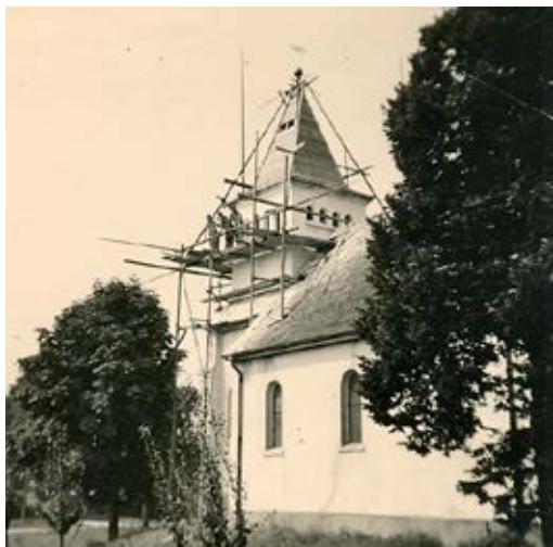
Juli 1951: die Arbeiten sind in vollem Gange
