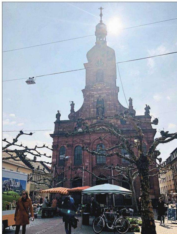
SCHWER ZU LÖSCHEN wäre ein Feuer in der katholischen Stadtkirche Sankt Alexander. Der Brandschutz ist noch ausbaufähig. Foto: Weisenburger
